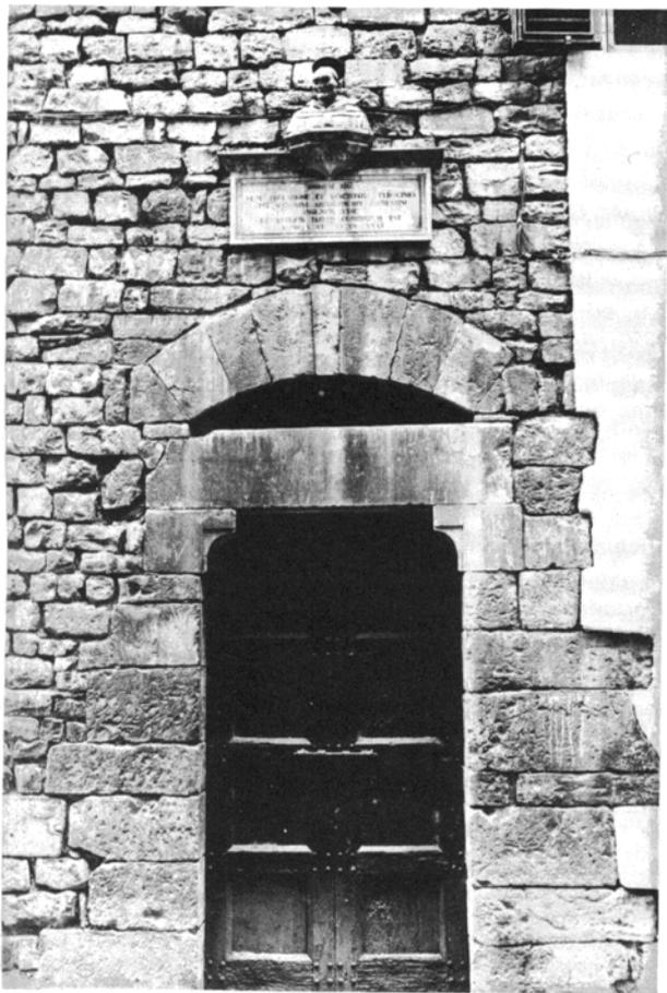
Fig. 5 - Notare il taglio al margine superiore sinistro dell'architrave della porta in proseguo della curva di intradosso dell'arco.
