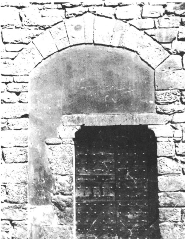
Fig. 4. Si noti il deterioramento dell'intradosso dell'arco in corrispondenza verticale al taglio netto dell'architrave della porta.
